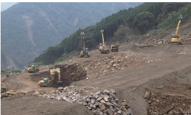
写真-5 崩壊地内で稼働する無人化施工機械
