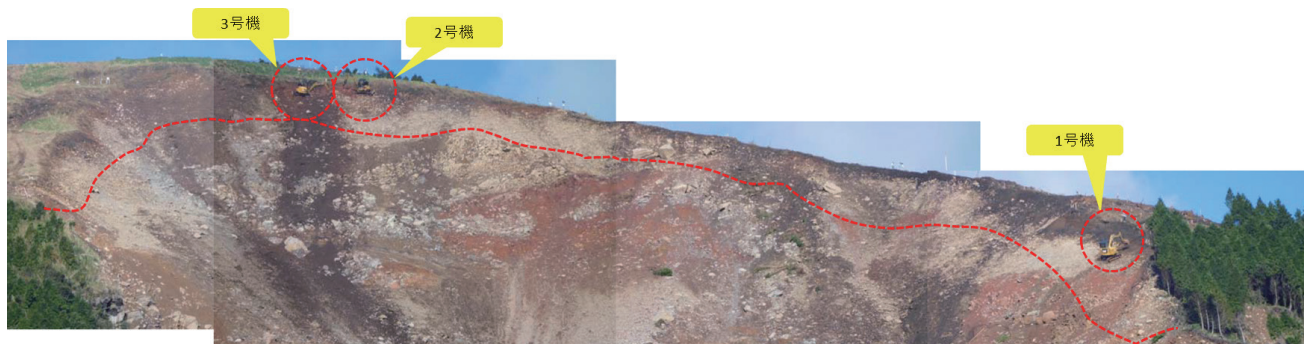
写真-17 3台の高所法面掘削機によるラウンディング作業状況
