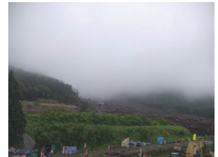
写真-8 濃霧による視界不良
