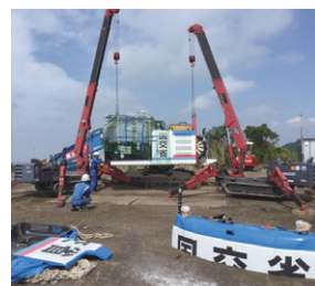
写真-13 頭部での重機組立状況
