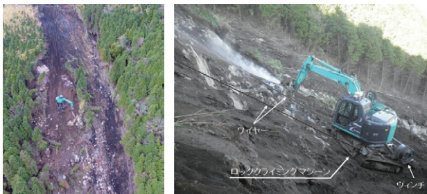
写真-21 ロッククライミングマシンの作業状況
