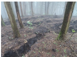
写真-3 開口亀裂の状況
